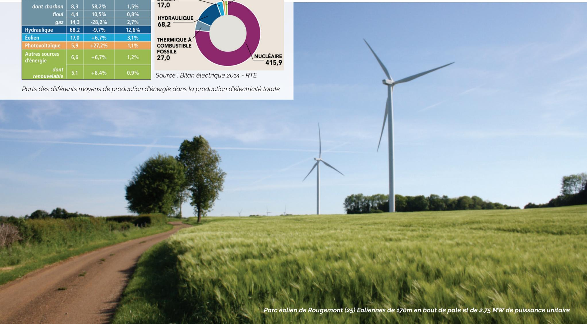
Parc éolien de Rougemont (25) Eoliennes de 170m en bout de pale et de 2,75 MW de puissance unitaire
